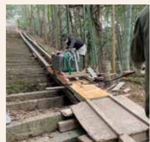
石材を搬入出するため、分厚い合板でスロープを作る
