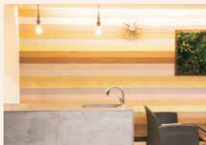
施工例としてクライアントに見せることもある、色々な左官塗材と技法を用いたオフィスの壁。手前のシンクに使っているのはベルギーの仕上げモルタル「モールドテックス」。
